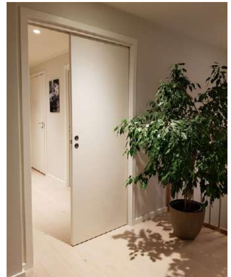
Pocket skyvedørskarm for montering i vegg.
